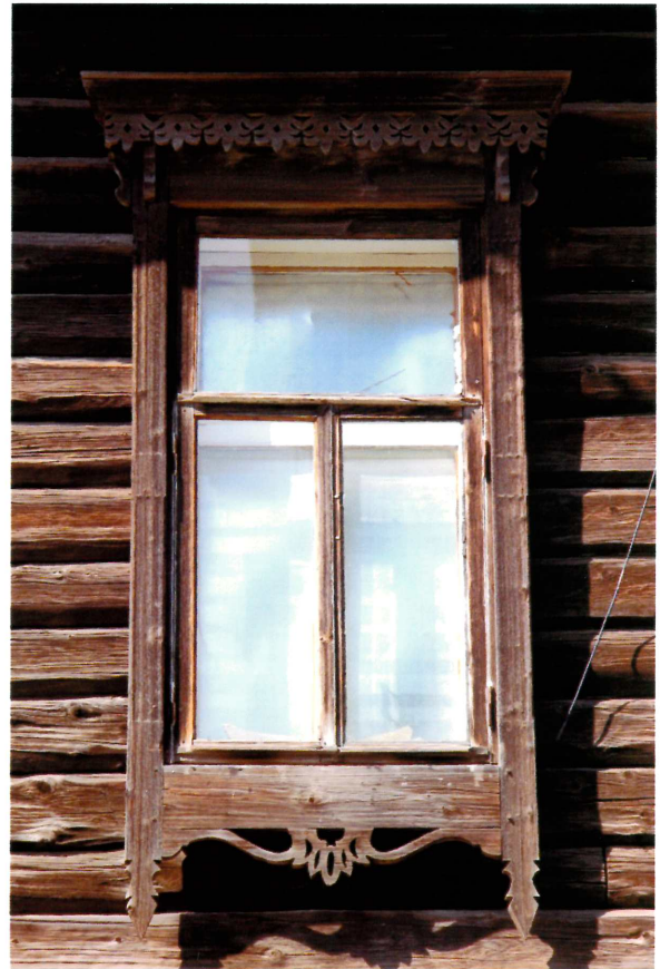
Видовая точка № 8. Прямоугольное окно 2-го этажа в обрамлении наличника. Главный фасад.
