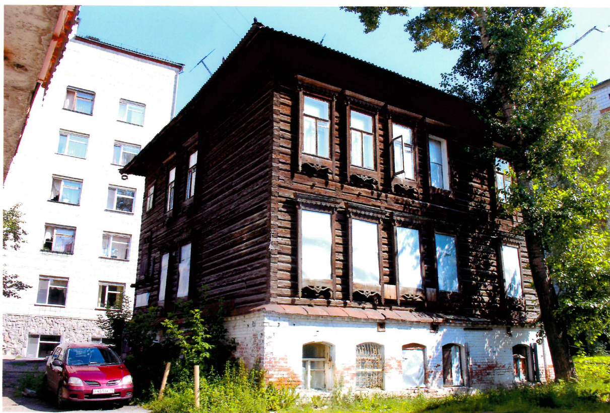
Видовая точка № 4. Западный фасад. Вид со двора.
