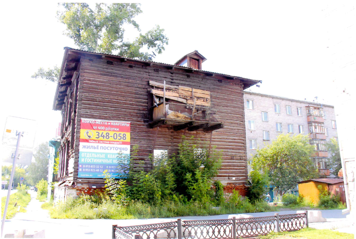
Видовая точка № 6. Восточный фасад Вид с ул. Савиных.
