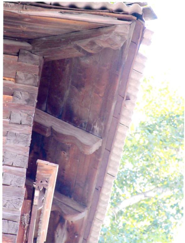
Видовая точка № 11. Фрагмент карниза с открытыми резными концами стропильных ног.
