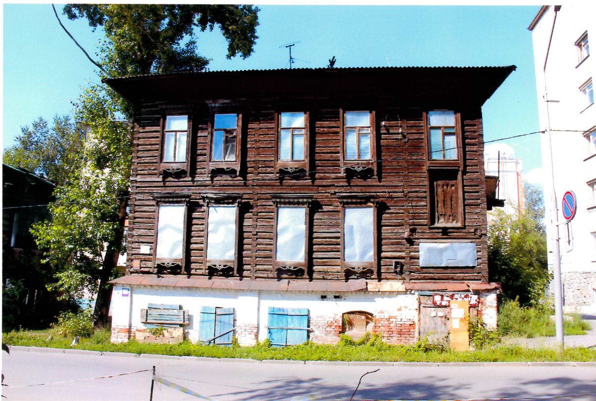
Видовая точка № 3. Главный (южный) фасад. Вид с ул. Савиных.
