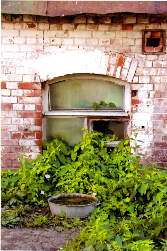
Видовая точка № 7. Лучковое окно 1-го этажа. Западный фасад.
