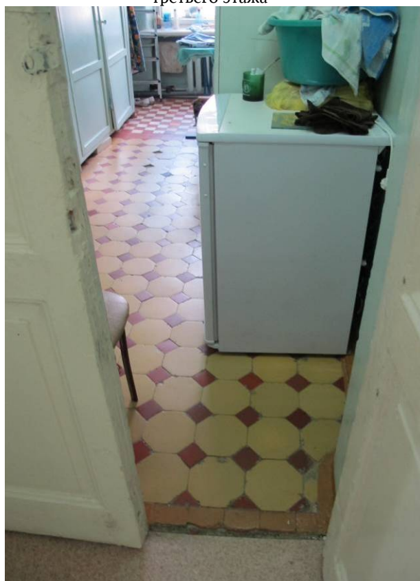
Видовая точка № 46. Метлахская керамическая плитка покрытия пола помещения
