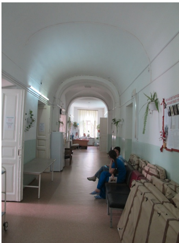
Видовая точка № 39. Коридор второго этажа с кирпичным цилиндрическим и крестовым сводами
