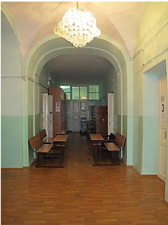
Видовая точка № 43. Коридор третьего этажа с крестовым сводом
