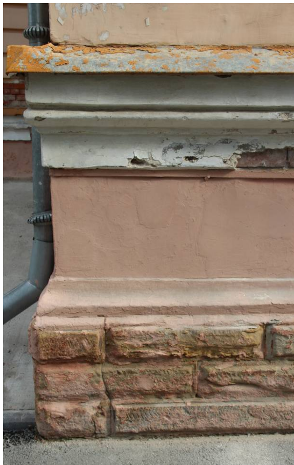
Видовая точка № 19. Фрагмент цокольной части южного фасада, профильные пояса и облицовка плитами песчаника
