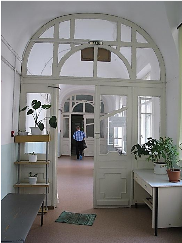
Видовая точка № 29. Деревянные остекленные перегородки коридора первого этажа
