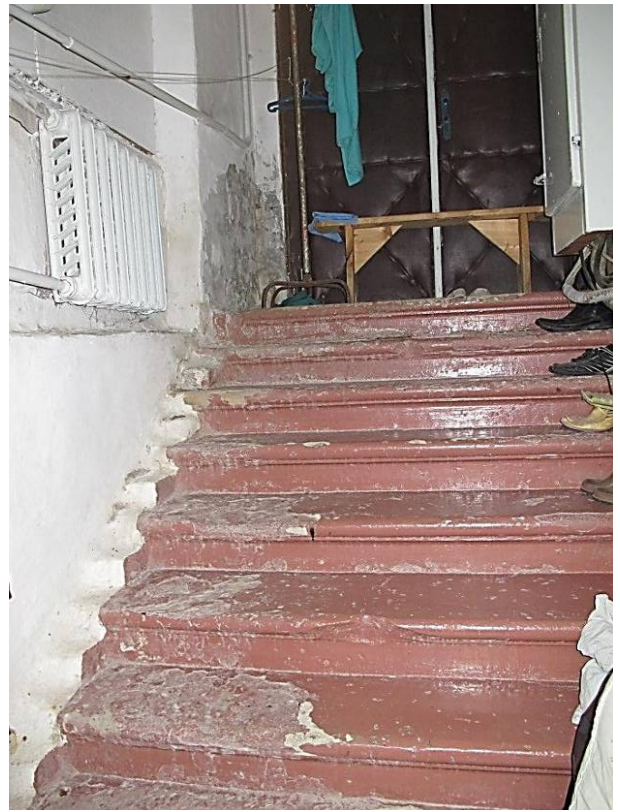
Видовая точка № 24. Одномаршевая лестница спуска в подвал
