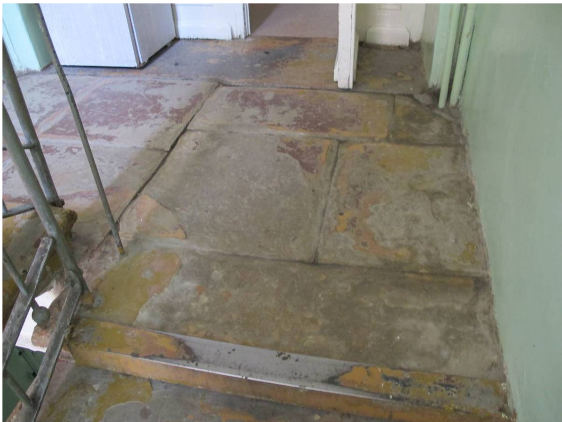
Видовая точка № 50. Покрытие лестничной площадки из плит песчаника
