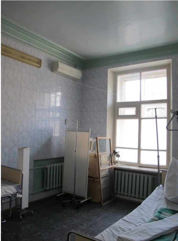
Видовая точка № 35. Потолочные тяги в помещении первого этажа
