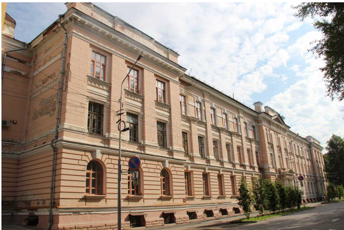
Видовая точка № 6. Южный фасад здания, вид с ул. Савиных
