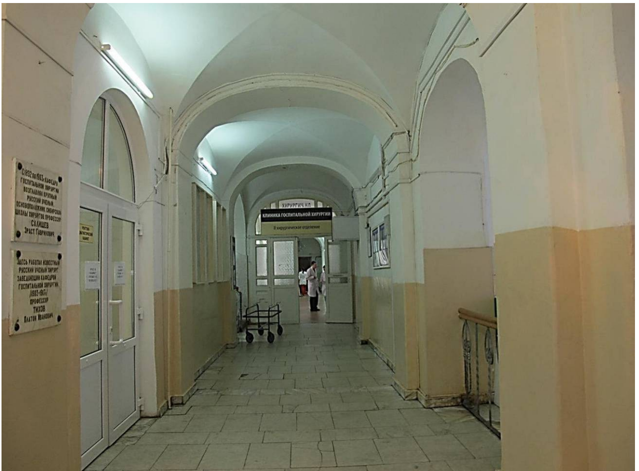
Видовая точка № 25. Коридор первого этажа (вестибюль), арки, крестовые своды перекрытие
