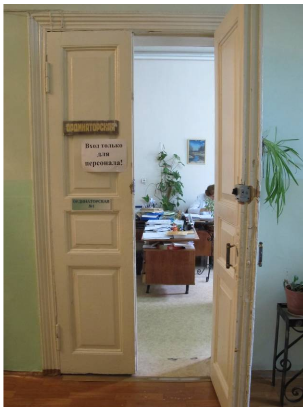
Видовая точка № 40. Деревянная филленчатая дверь с латунными дверными ручками
