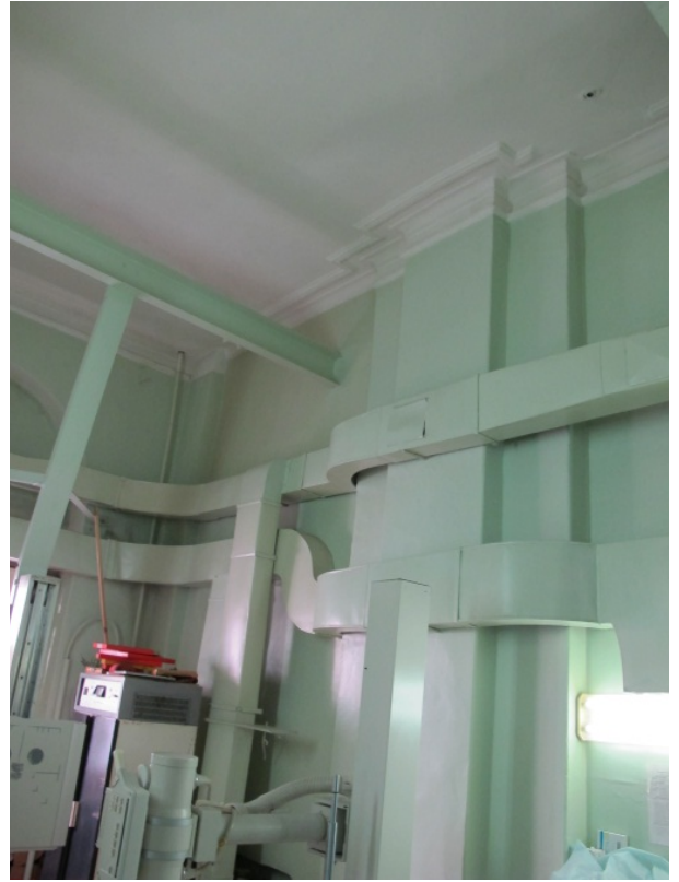
Видовая точка № 36. Потолочные тяги и пилястры в помещении первого этажа
