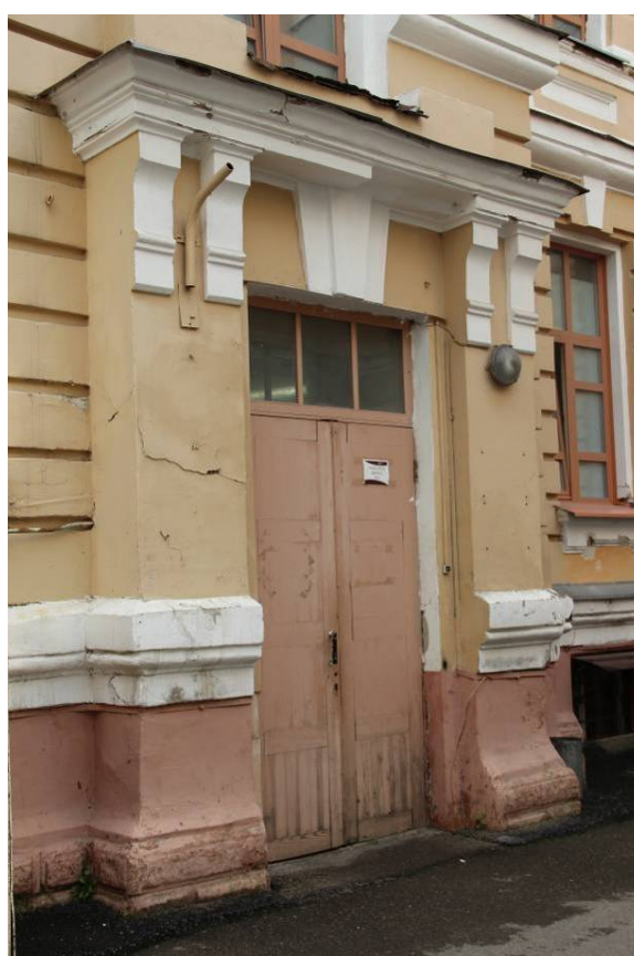
Видовая точка № 12. Портал дворового входа
