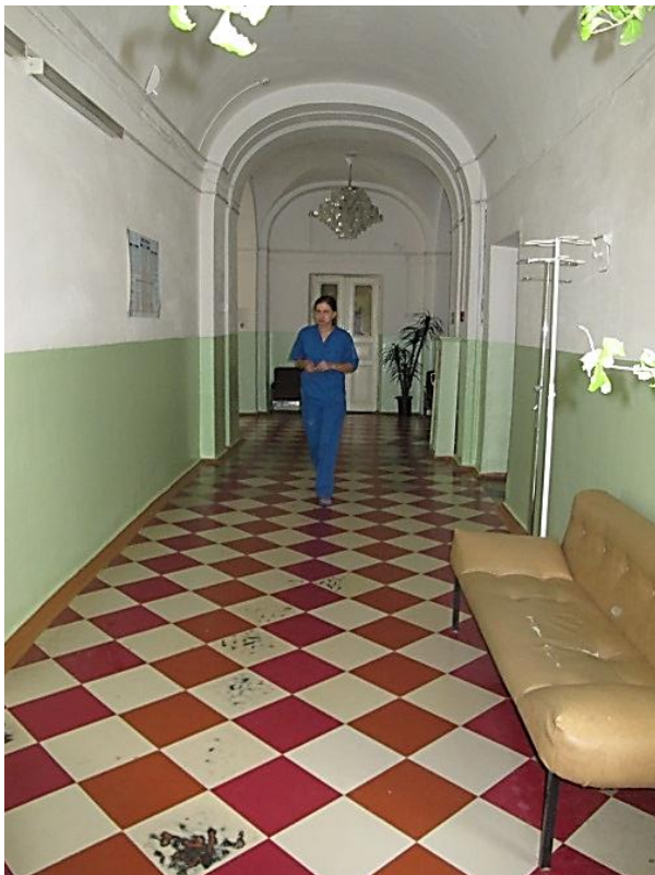
Видовая точка № 37. Коридор первого этажа с кирпичным цилиндрическим сводом
