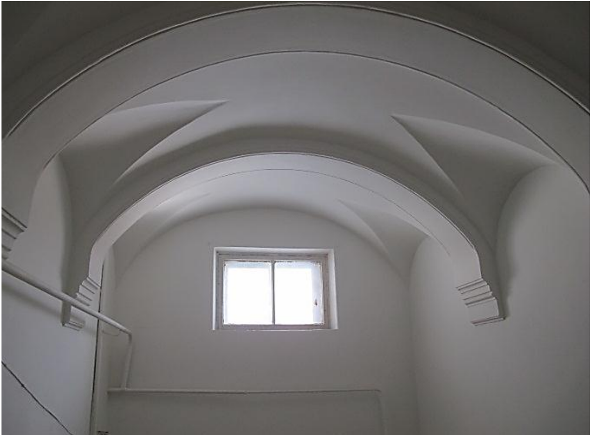
Видовая точка № 33. Цилиндрический свод с распалубками над центральной лестницей
