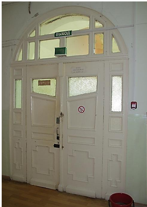
Видовая точка № 44. Деревянная остекленная перегородка третьего этажа
