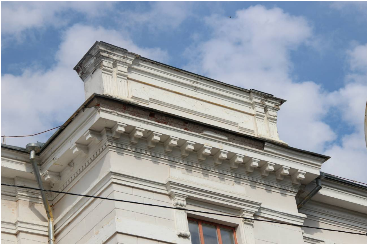
Видовая точка № 5. Фрагмент восточного фасада, карниз и аттик
