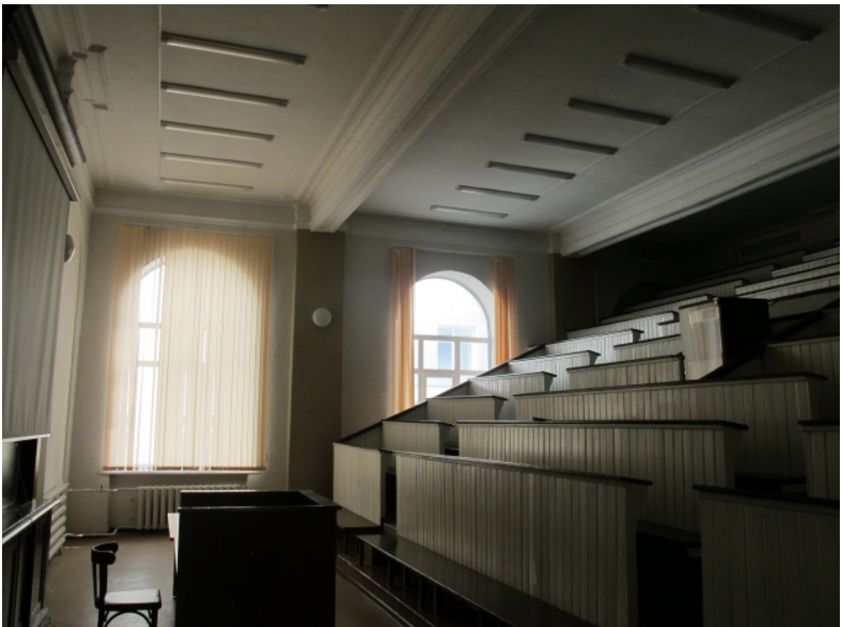
Видовая точка № 34. Зал первого этажа с кессонными перекрытиями
