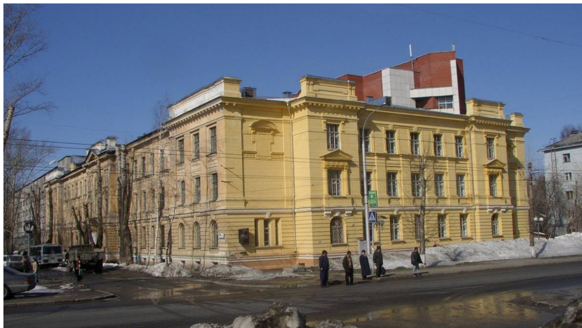
Видовая точка № 2. Общий вид здания с пр. Ленина (автор снимка: Яблонская М.А., дата съемки: 2004 г.)
