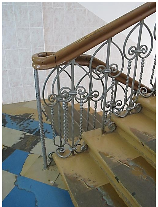
Видовая точка № 32. Фрагмент ограждения лестницы
