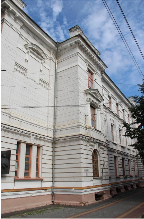
Видовая точка № 3. Главный восточный фасад
