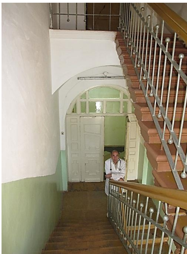
Видовая точка № 45. Двухмаршевая лестница из песчаника (западного крыла) с подъемом на чердак
