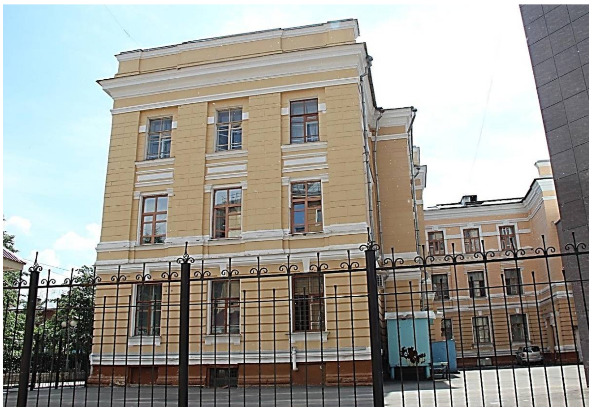
Видовая точка № 20. Северный фасад правого крыла здания (Монич Г.И., 01.07.2014)
