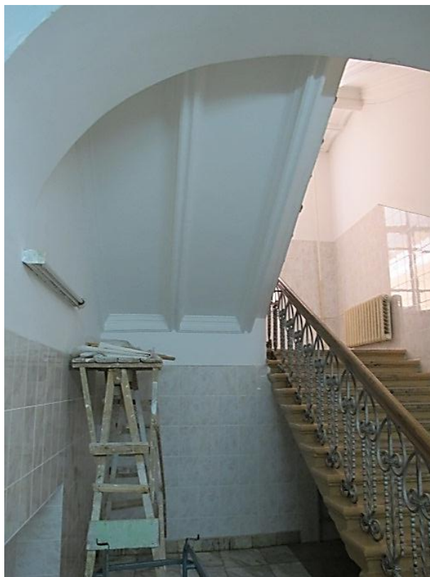
Видовая точка № 31. Двухмаршевая лестница из песчаника, профильная отделка нижней поверхности марша
