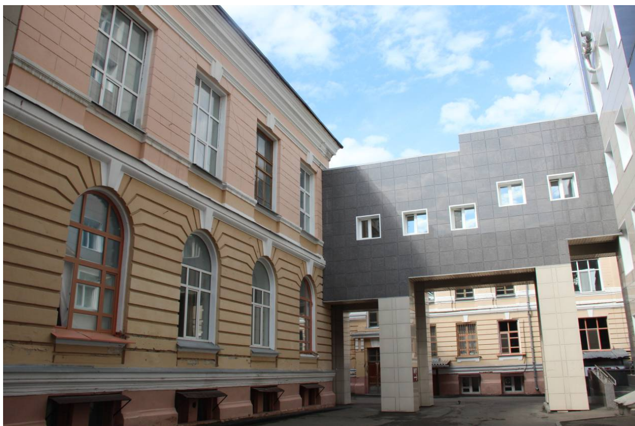
Видовая точка № 17. Фрагмент северного фасада центрального 2-х этажного объема
