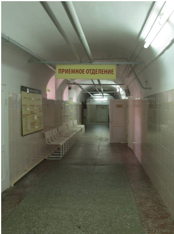
Видовая точка № 23. Общий вид коридора подвала
