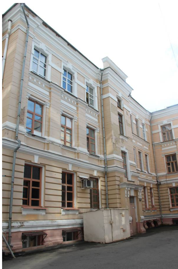
Видовая точка № 14. Восточное крыло здания, фрагмент дворового фасада
