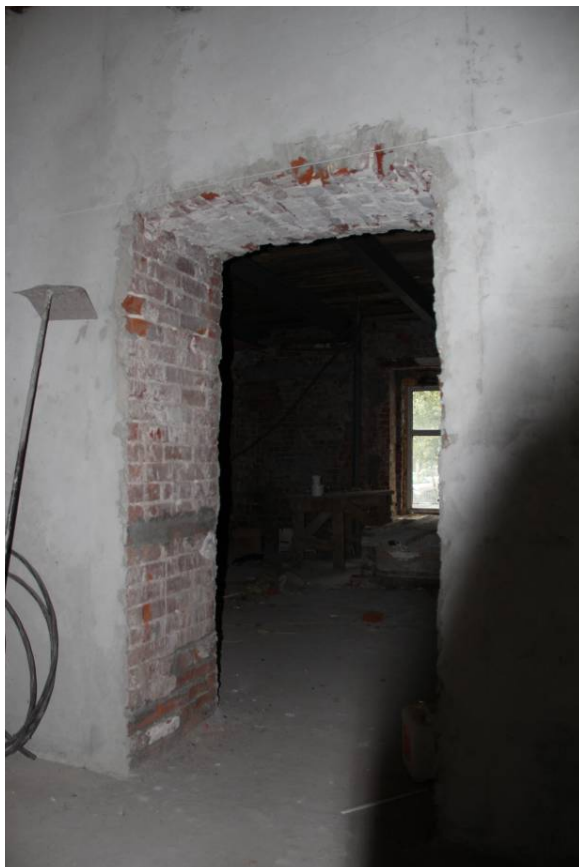
Видовая точка № 13. Дверной проем с лучковой перемычкой (Леонтьева Н.М., 02.07.2017 г.)
