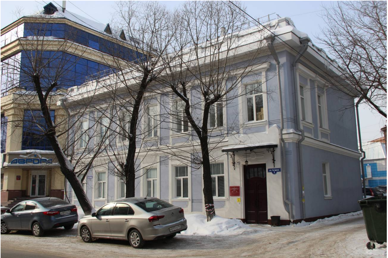
Видовая точка № 3. Главный (восточный) фасад здания
