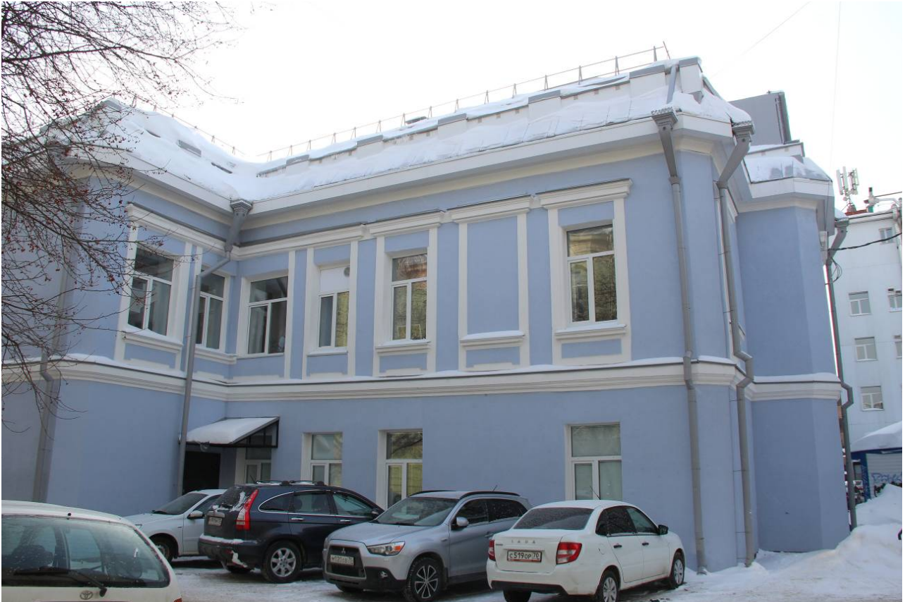
Видовая точка № 9. Фрагмент дворового (северного) фасада
