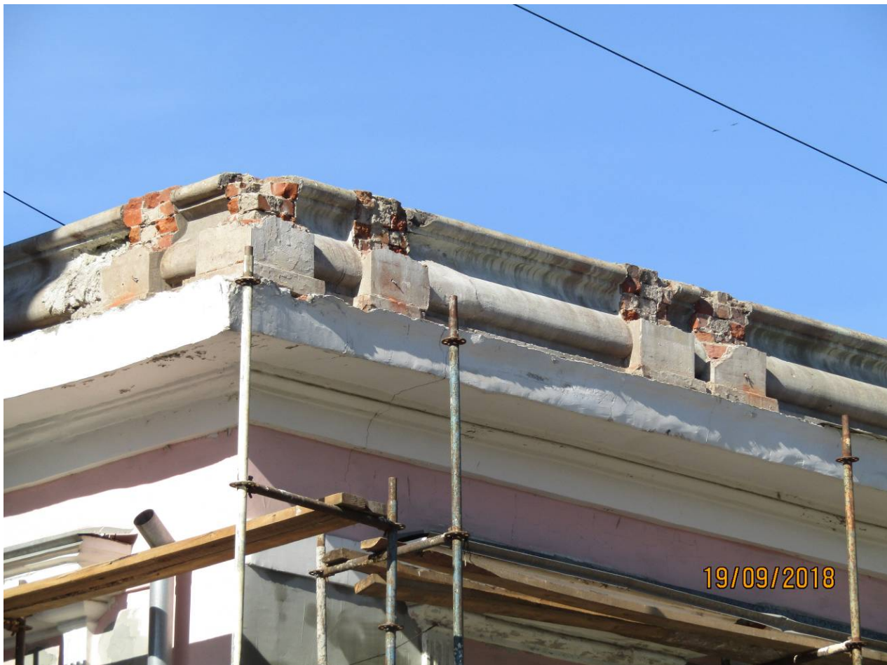
Видовая точка № 11. Фрагмент венчающего карниза с кирпичным парапетом (Леонтьева Н.М., 19.09.2018 г.)
