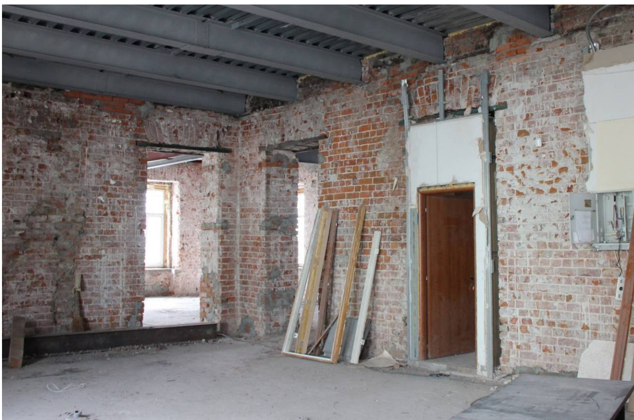
Видовая точка № 12. Высокие дверные проемы с кирпичными лучковыми перемычками для дверей с остекленными фрамугами (Рыжикова А.Ю., 24.05.2017 г.)
