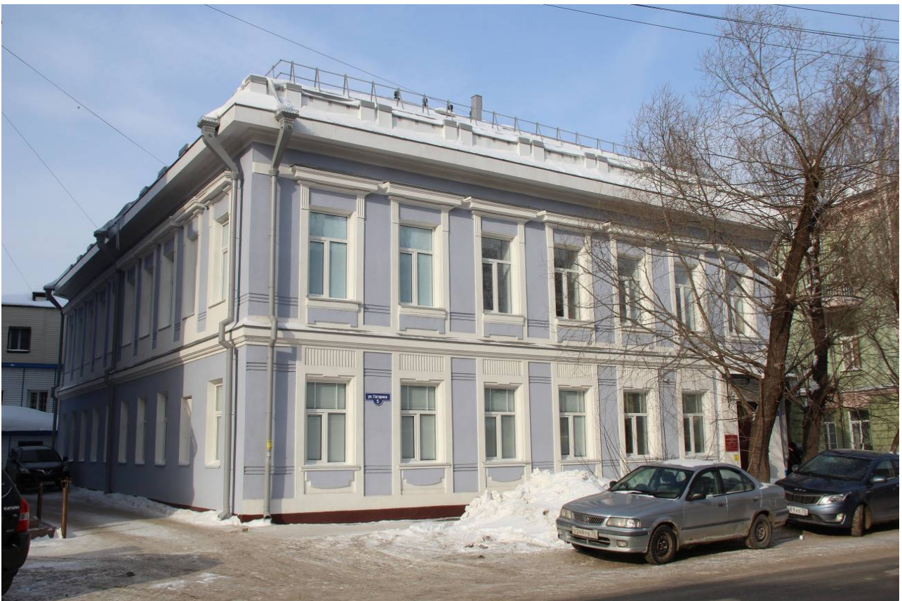
Видовая точка № 4. Главный (восточный) фасад здания
